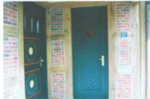
Hochwertige Eingangstür – Tür zum Abstell-/Technikraum
