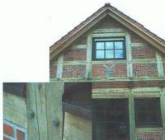
Man erkennt die Liebe zum Detail – Windmühle im Giebelbereich - Holzverzäpfungen
