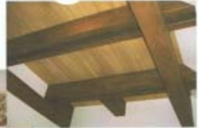
Holzbalkendecke im Schlafz.
