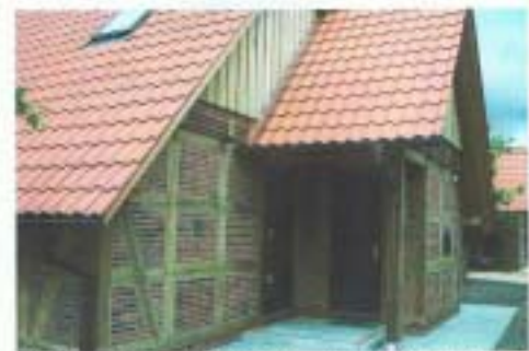
Überdachter Eingangsbereich – Abstell-/Technikraum und über dem Abstell-/Technikraum noch ein Abstellr.
